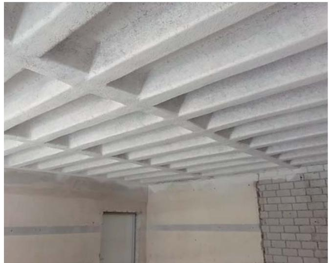
*Brandschutzputz auf Decke und mit weißer Farbe übersprüht. Das wird das neue Deckenmuster im vorderen und hinteren Bereich des Fitness-Centers. Der Mittelbereich hat eine glatte Decke, allerdings dieselbe Oberflächenstruktur.*
