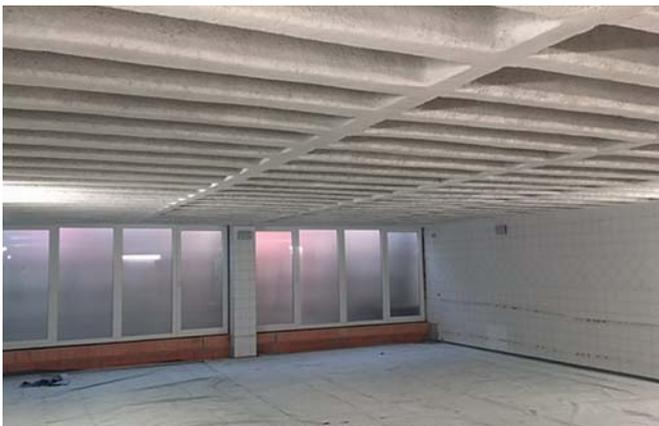
*Neue Fensterfront im hinteren Bereich (ehemaliges Schwimmbad). Unmittelbar vor der Fensterfront wird der neue Mattenbereich platziert. An der Unterkante der Fenster ist eine Aufmauerung zu erkennen, die nötig war, um die Kosten für die Fenster deutlich zu senken.
