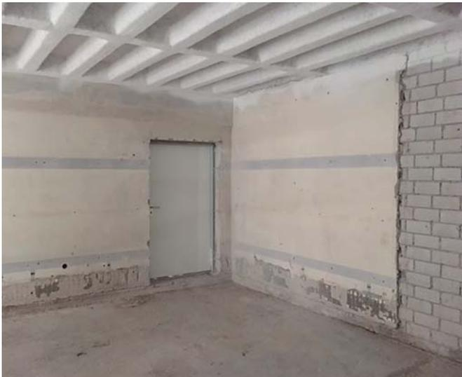
*Einbau Fluchtwegtür im vorderen Bereich des neuen Fitness-Centers mit Fluchtrichtung hin zum großen Flur.
