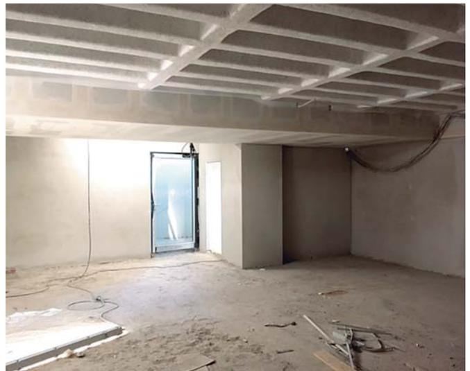
*Auch der Innenputz ist bereits aufgebracht – der nächste Schritt wird der Einbau des Estrich sein....*
