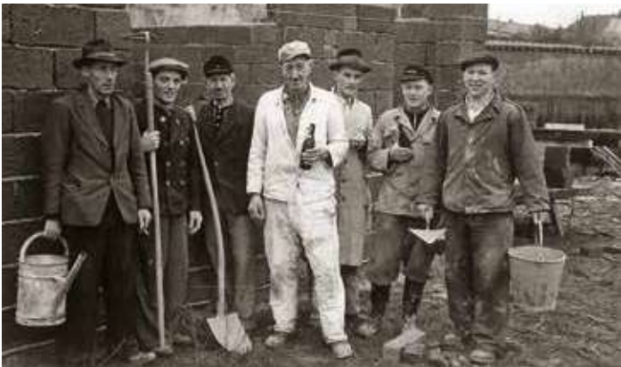
Bau der Umkleiden und des Geräteraums 1951/52
