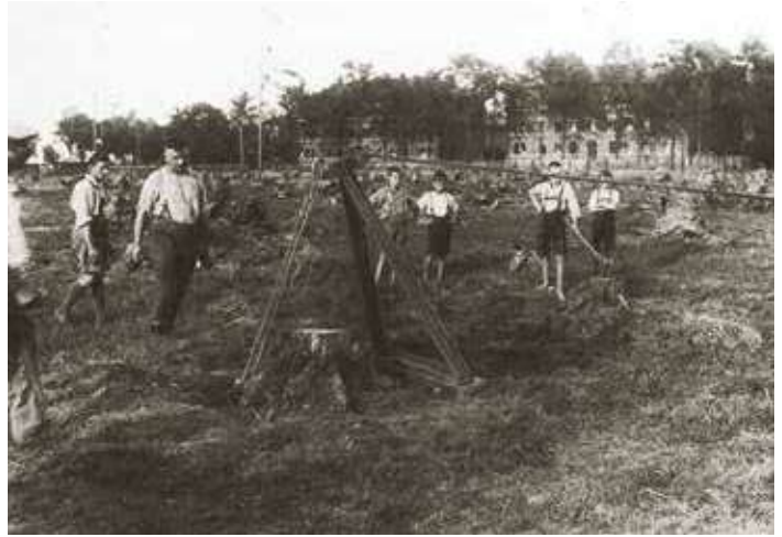
Rodung des Sportplatzes dank freiwilliger Arbeitsleistungen
