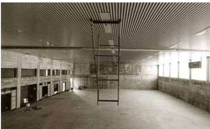
Rohbau der großen Dreifachturnhalle
