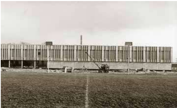
West-Ansicht des neuen Hallenkomplexes in der Bauphase
