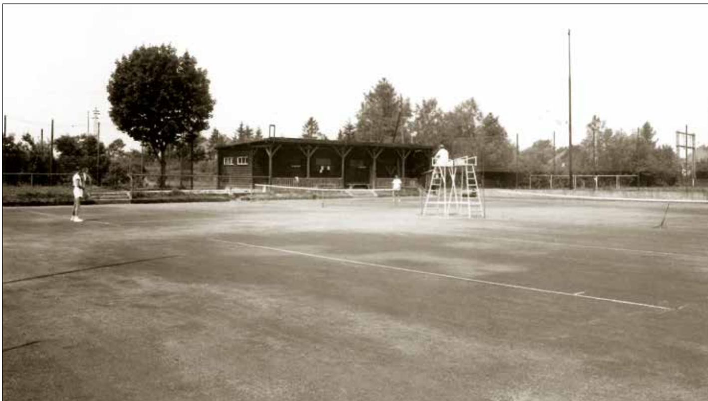
Zwei Tennisplätze inkl. Clubhaus nach der Sanierung in den 1950er-Jahren
