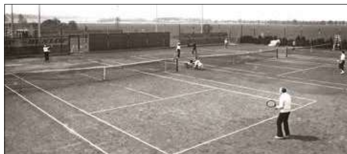
Tennisanlage der 70er-Jahre...
