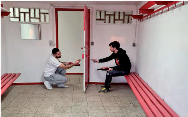
Es wurden Bänke und Ablagen abgebaut, abgeschliffen und in rot oder weiss lackiert, nasser Putz von den Wänden geschlagen und neu
